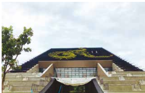
สภาพการดำเนินงานแล้วเสร็จ ณ วันที่ ๑๓ กันยายน ๒๕๖๑
