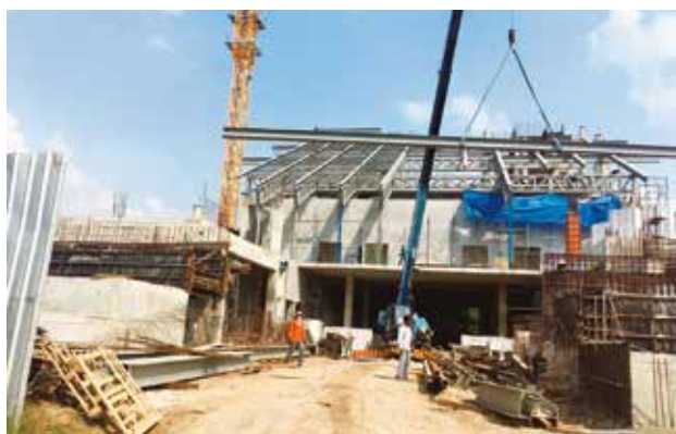
การดำเนินงานก่อสร้าง ช่วงเดือนกุมภาพันธ์ ๒๕๖๑
