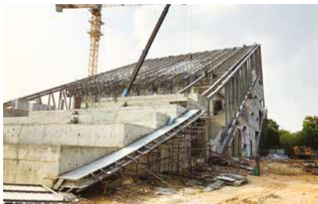
การดำเนินงานก่อสร้าง ช่วงเดือนสิงหาคม ๒๕๖๑
