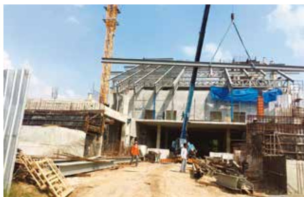
การดำเนินงานก่อสร้าง ช่วงเดือนมีนาคม ๒๕๖๑
