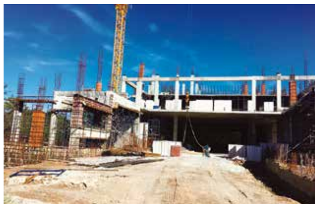
การดำเนินงานก่อสร้าง ช่วงเดือนพฤศจิกายน ๒๕๖๐
